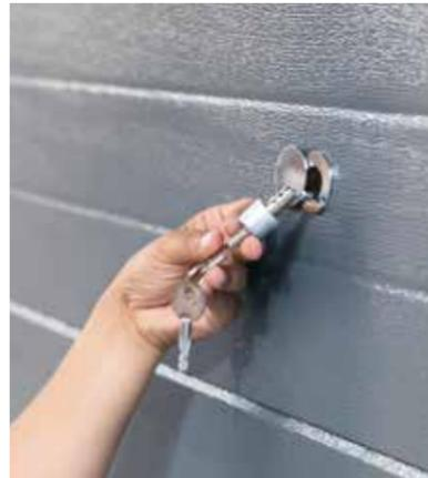
Desbloqueo de llave exterior (motor de techo)
