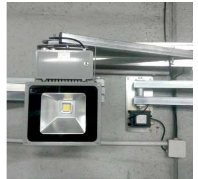
Die Rampenleuchte ist ein geeignetes Zubehör, um das Fahrzeuginnere beim Be- und Entladen zu beleuchten.
