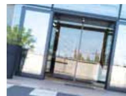
Portas Automáticas de Vidro Automatic Glass Doors
